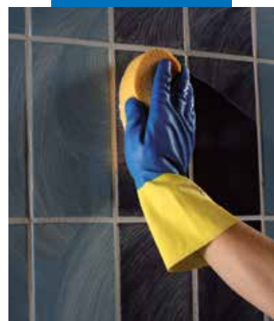
Czyszczenie i profilowanie celulozową gąbką
